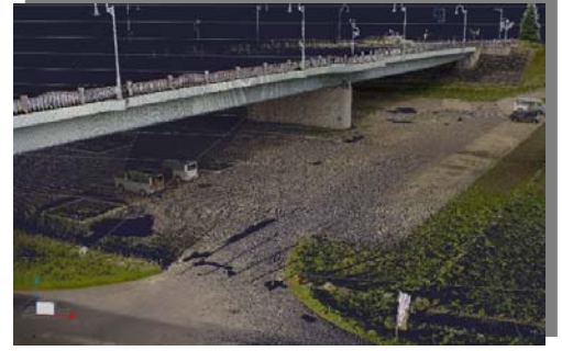
地形測量（地上レーザスキャナ）
