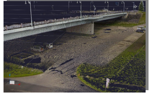
地形測量（地上レーザスキャナ）
