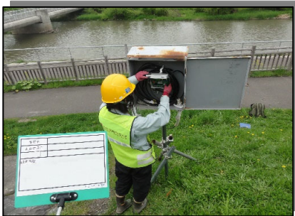
水位調査風景
